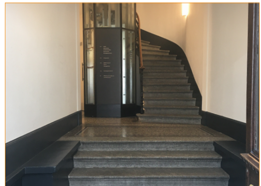
Qualité spatiale de la cage d'escalier Cage d'escalier attrayant, différenciée et équilibrée dans l'espace.
