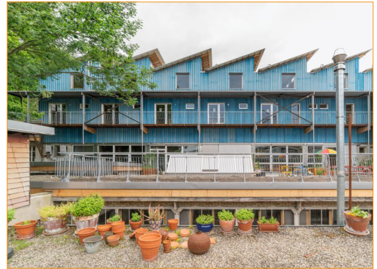
Surélévation de la Grubenstrasse à Zurich Source : https://insitu.ch/projekte/351-aufstockung-grubenstrasse
