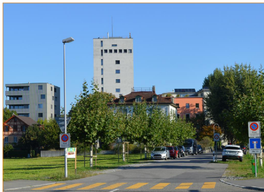
Réaffectation d'un moulin en « silo d'habitation » à Baar
