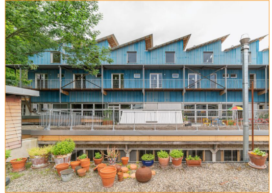
Aufstockung Grubenstrasse Zürich Quelle: https://insitu.ch/projekte/351-aufstockung-grubenstrasse
