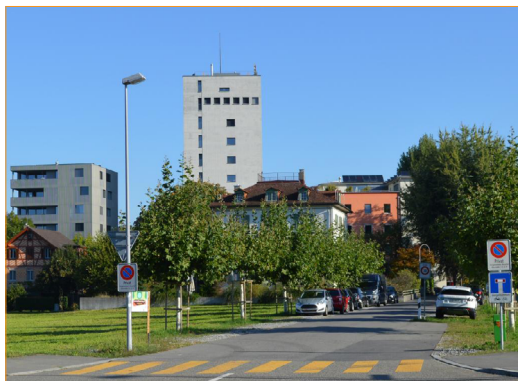
Umnutzung von Mühle zu «Wohnsilo» in Baar Quelle: https://www.densipedia.ch/die-obermuehle-wird-umgenutzt-und-ihr-silo-mit-leben-gefuellt
