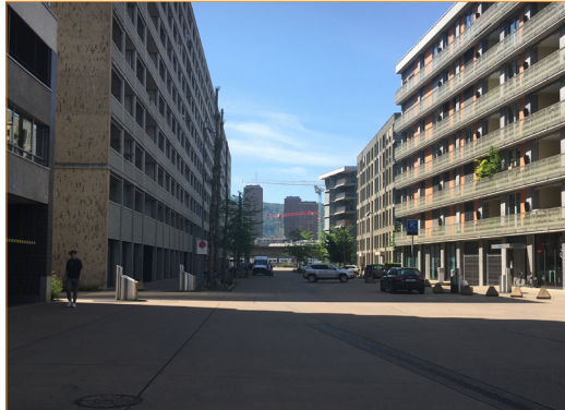
Freiraumgestaltung Der Aussenraum ist gänzlich ungestaltet.
