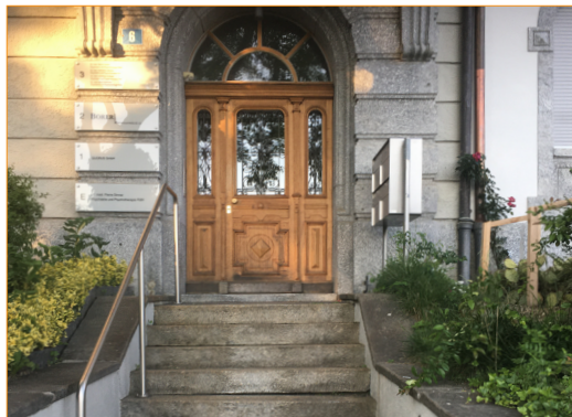
Räumliche Qualität des Hauseingangs Einladend gestalteter und materialisierter Hauseingang.
